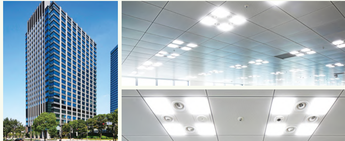
Mビル 2017年 空気式・金属放射パネル、 中温熱源、冷媒自然循環システム、冷温水式外調機(冷却除湿)
