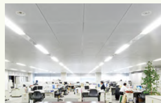
Hビル 2016年 水式・金属放射パネル、 冷温水式デシカント(全熱交換器組込)
